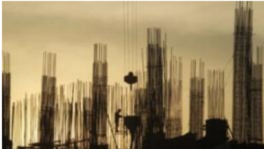
Công nhân làm việc tại một công trường xây dựng ở Hà Nội
